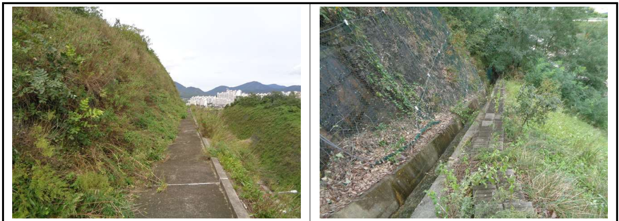
【그림 7.3.3】 배수시설 전경
